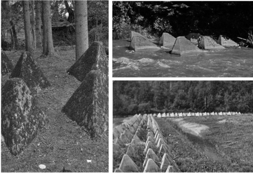
Рис. 7. Протитанкові залізобетонні тетраедри. Лінія Арпада, місце зйомки невідоме (Венгрія., 2018; Bădescu, 2015a)
